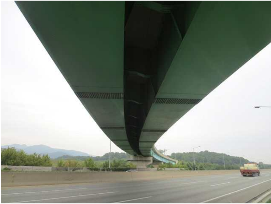
바닥판하면 및 강박스 외부전경
